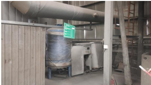
DA077 采样平台
